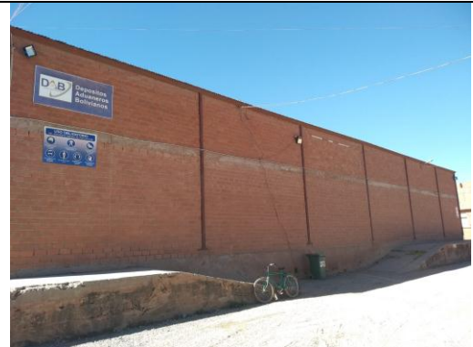
Reposición de luminarias
