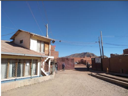
Reposición de luminarias
