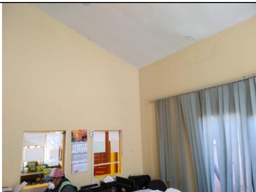
Pintura interior latex
