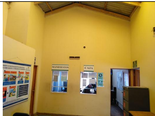
Pintura interior latex
